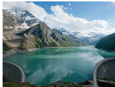
Az ausztriai Kaplung Limberg II. szivattyús-tározós erőmű
